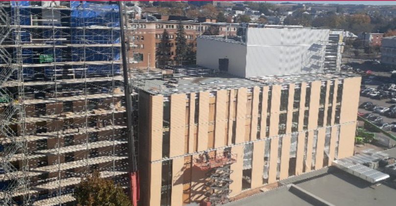
Dès le début de novembre, la maçonnerie sera quasi terminée sur les côtés est et ouest. Par contre, celle de l'abri de vélos se poursuivra.
