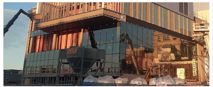
L'installation du mur rideau se poursuit à un rythme soutenu.
