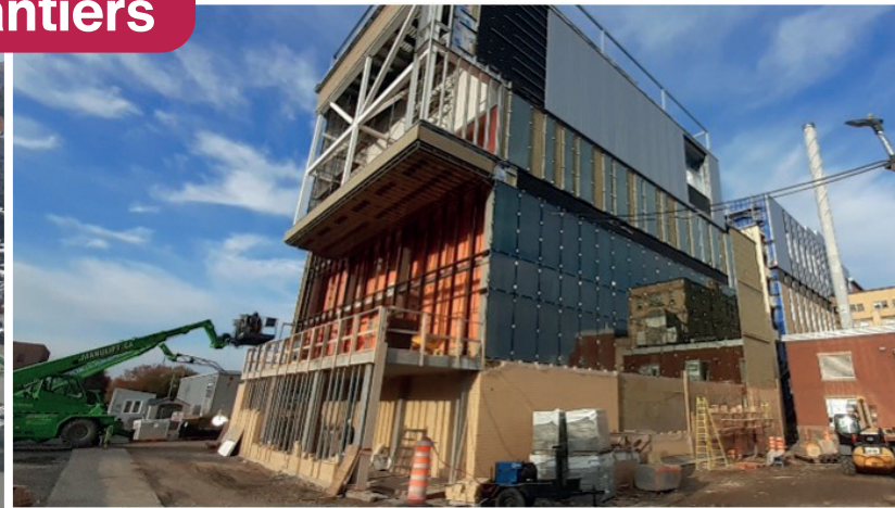
Façade sud-est. L'abri de vélos au rez-de-chaussée s'érige peu à peu.
