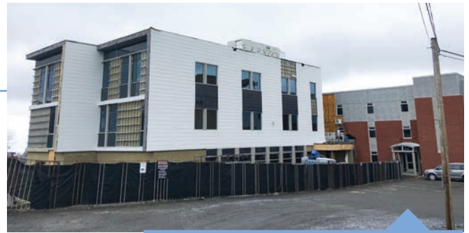
Pose du revêtement extérieur
