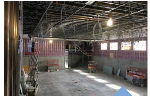
Sous-sol de la partie agrandissement | Gymnase
