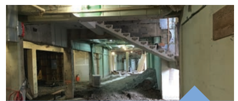
Bâtiment existant | Démolition au sous-sol
