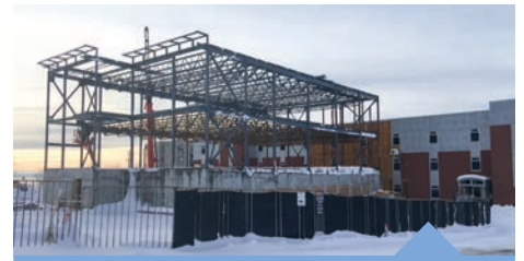
Érection de la structure
