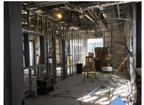
Construction de cloisons au 3 e étage de l'agrandissement | Bureau des éducateurs
